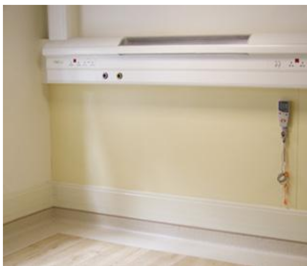
Deco és Urban szegélyradiátor profil összeépítése kórház felújításnál
